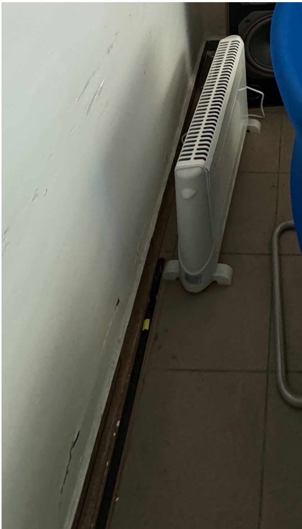
Zdjęcie 9 – Spękania i odspojenia tynków wewnętrznych
