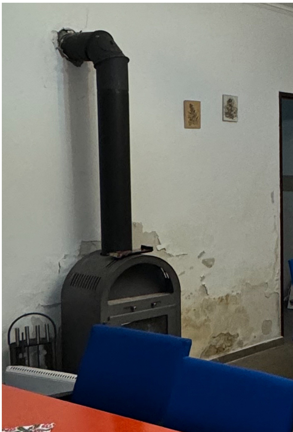
Zdjęcie 8 – Przestarzałe instalacje wewnętrzne. Zawilgocenie ścian wewnętrznych, uszkodzenie tynku, spękania i wybrzuszenia.
