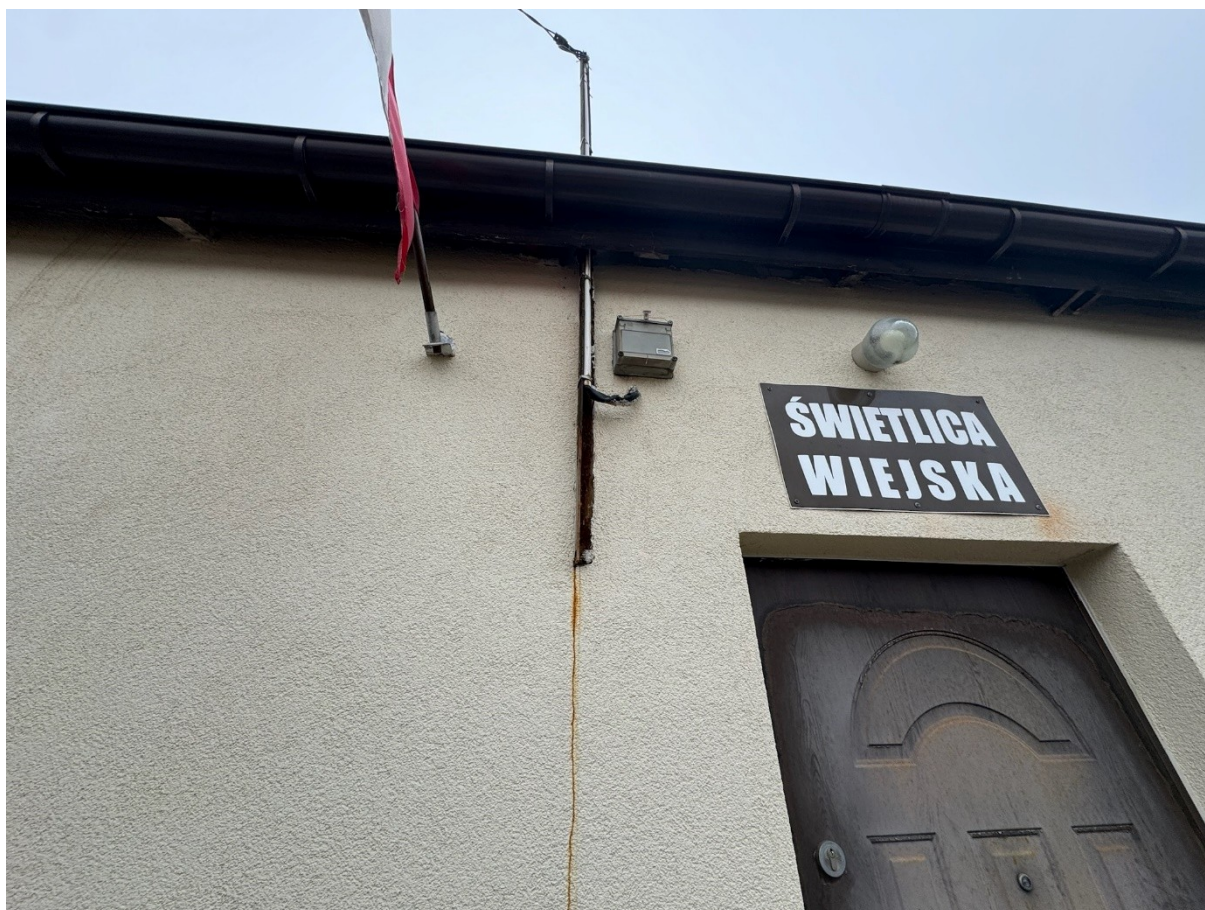
Zdjęcie 5 – Przestarzałe instalacje w obrębie elewacji frontowej obiektu. Uszkodzenie tynków. Uszkodzenie drzwi wejściowych.
