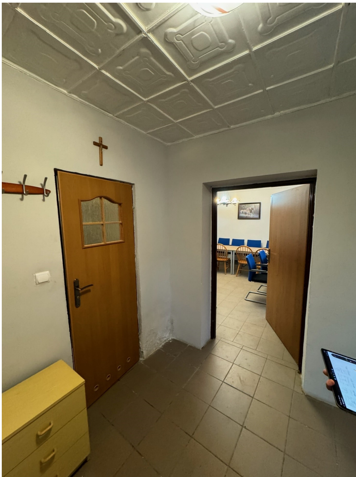
Zdjęcie 10 – Zawilgocenie ścian wewnętrznych. Spękanie i odspojenie tynków wewnętrznych do wysokości 1 m w obrębie strefy wejściowej.
